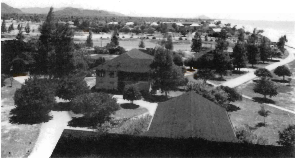
พระตำหนักปลูกเกษมและเรือนเอิมเปรม มองจากหอคอยพระตำหนักเปี่ยมสุข เห็นหลังคาศาลาเรียงพร้อมคอร์ทสควอชอยู่ด้านล่างของภาพ และช่องโค้งห้องเครื่องอยู่ด้านซ้าย
