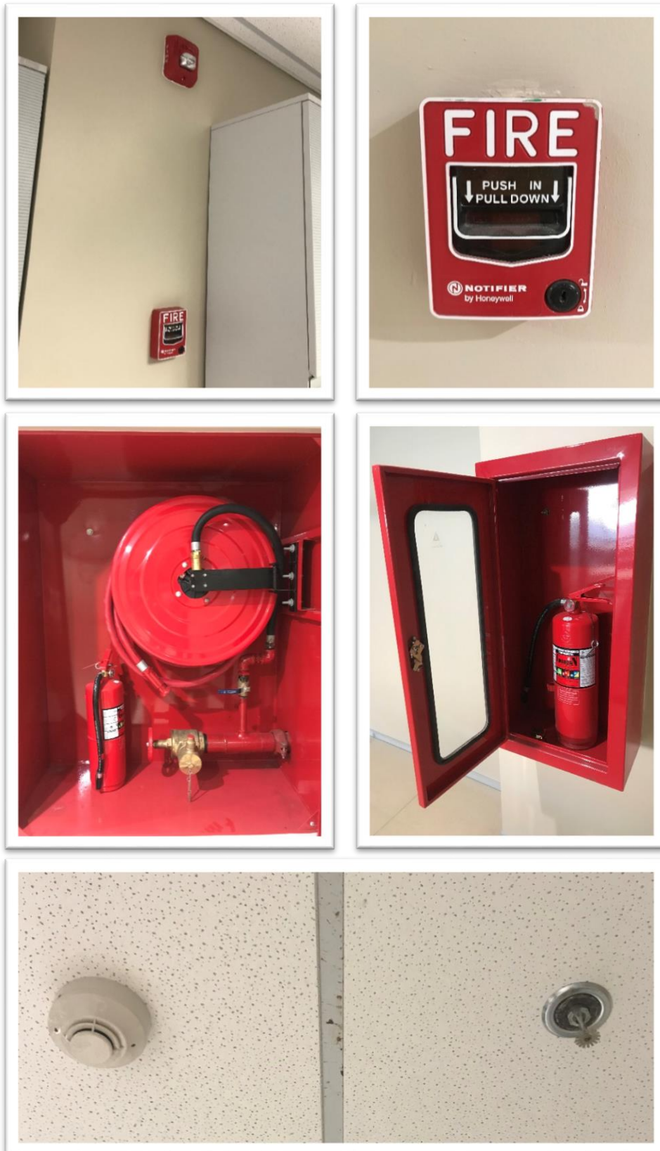
การติดตั้งอุปกรณ์ดับเพลิงและระบบสัญญาณเตือนภัยภายในสำนักงานพิมพ์
