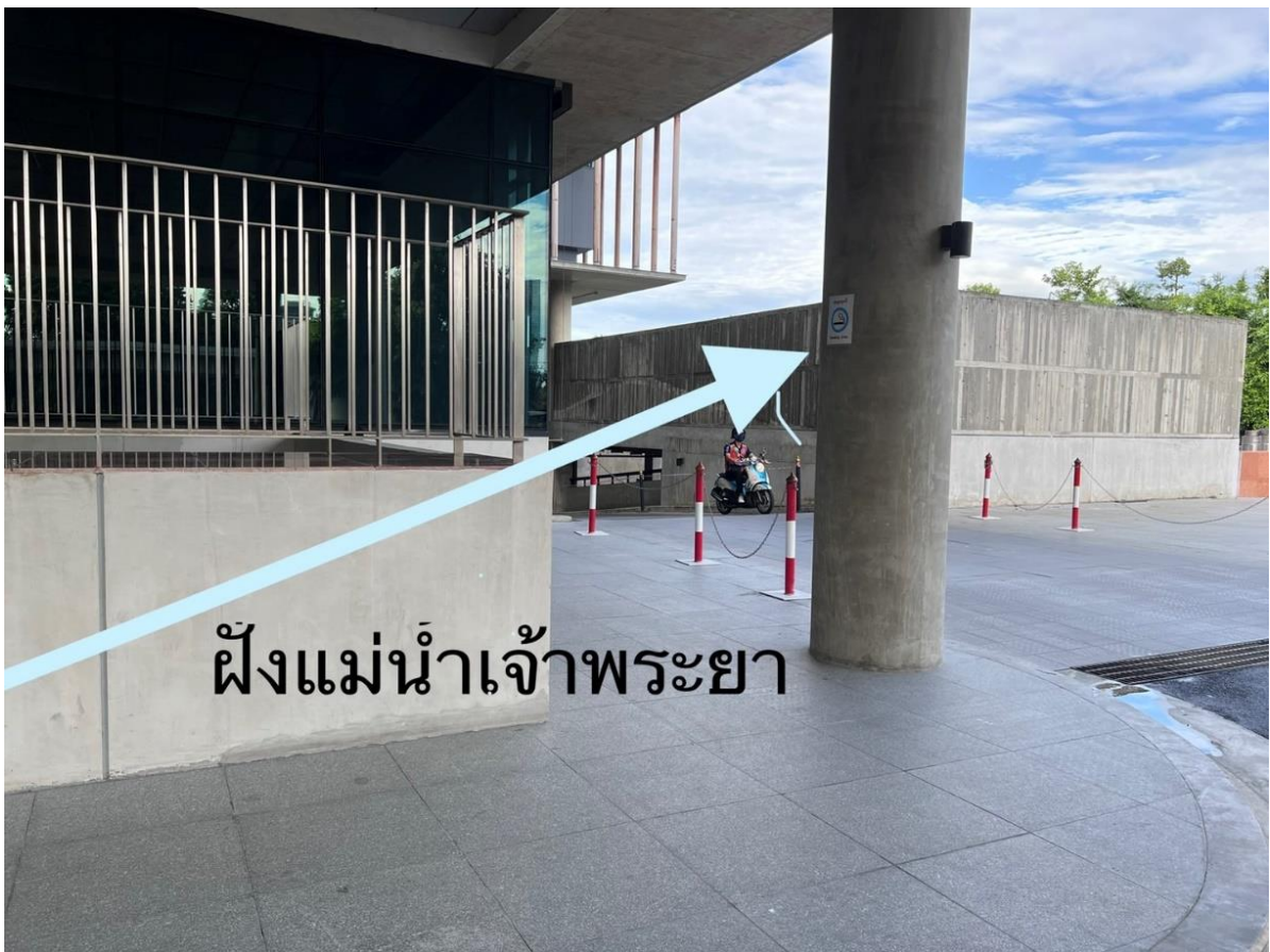
จุดที่ 2 ภายนอกอาคารบริเวณชั้น 1 อาคารรัฐสภา ฝั่งแม่น้ำเจ้าพระยา อาคารรัฐสภา เกียกกาย
